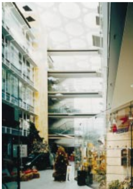
Neubau der Volksbank Pforzheim: das „Litewall“-Punkthaltesystem von Eckelt Glas im Atrium der Ladenstraße ergänzt das transparente Ambiente des Gesamtkomplexes
