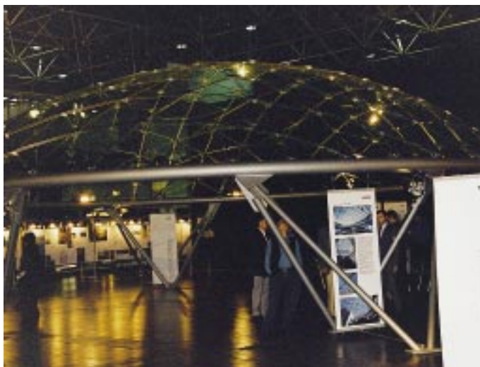
Messe-Highlight in Halle 9: Die selbsttragende Ganz-Glas-Kuppel mit einem Durchmesser von 12,5 m – eine der größten dieser Art
