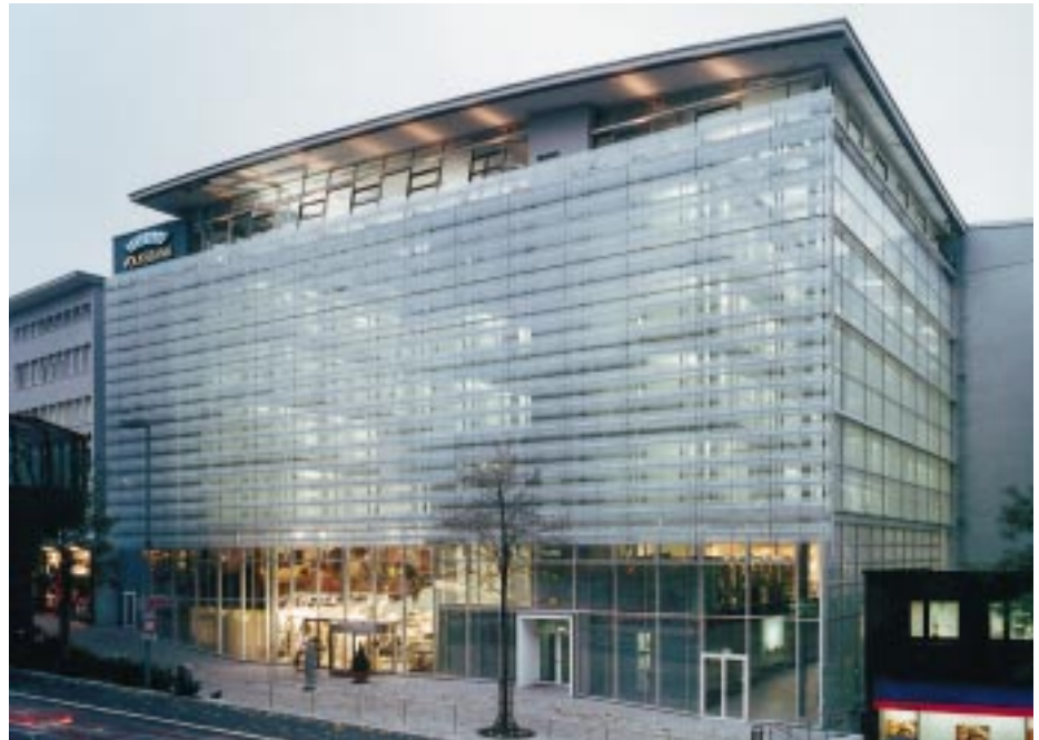
Die äußere gläserne Hülle besteht an der Hauptfassade aus großflächigen, beweglichen, punktgehaltenen Glaslamellen
