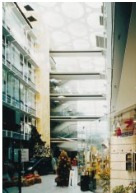
Das „Litewall“-Punkthaltesystem von Eckelt Glas – als Ganzglaskonstruktion im Atrium der Ladenstraße – ergänzt das transparente Ambiente des Gesamtkomplexes Bilder: Eckelt
