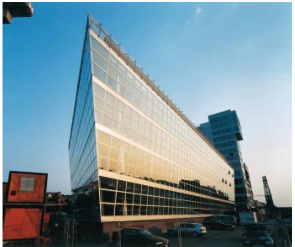
„Klar Schiff“ gemacht im übertragenen, architektonischen Sinn: Das Kai-Center in Düsseldorf mit seiner beeindruckenden, angeschrägten Structural Glazing-Fassade
