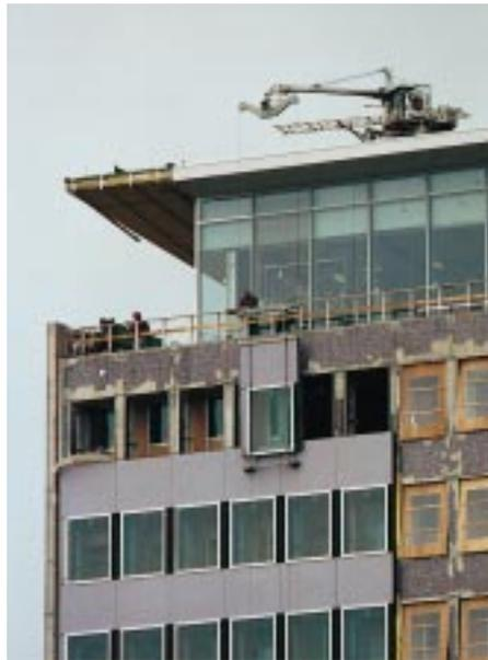
*Komplett vorgefertigte Fassadenelemente ermöglichten eine rationelle Montage
