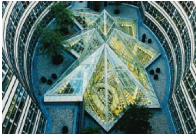
Brandschutzglas bildet ein wesentliches Element in der Gestaltung der Berliner Friedrichstadt-Passage
