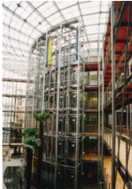
„Pyran S“ Brandschutz-Sicherheitsglas im Stahlrahmensystem „Leininger G 30“ schtzt Fluchtwege im Treppenhaus der Deutsch. Herold Versicherung, Bonn
