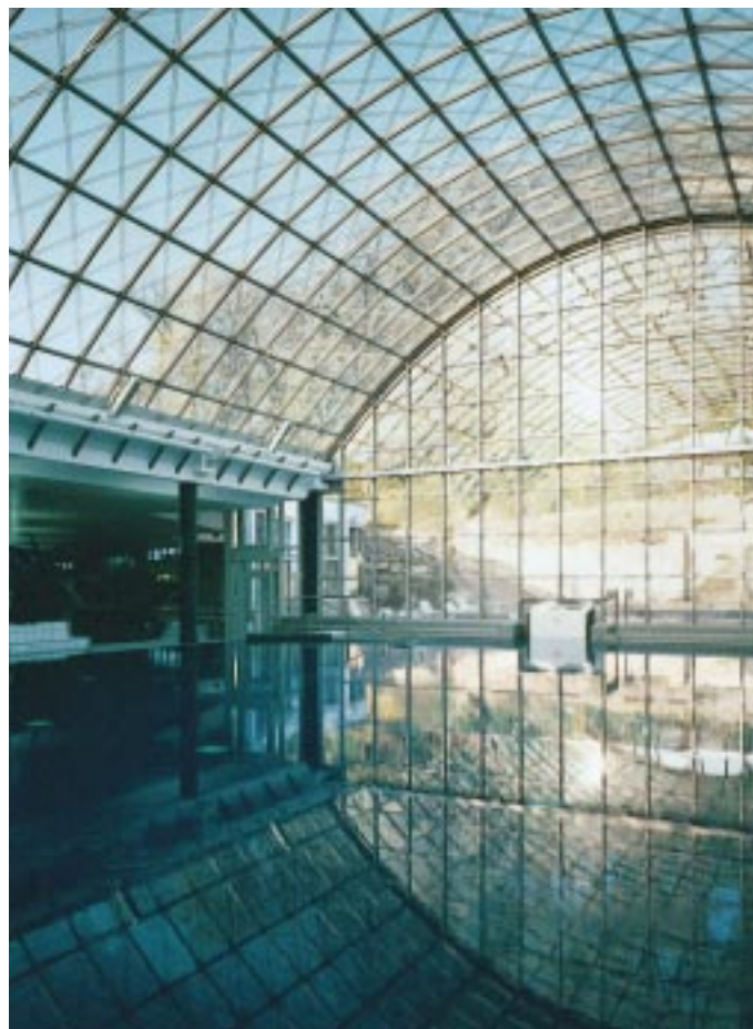
Glashaus ohne Treibhauseffekt: „Infrastop“-Fassaden- und Dachkonstruktion im Mineralbad Bad Cannstatt, Stuttgart
