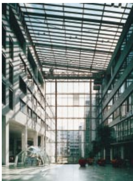
Lichteinfall und Schutz vor Überhitzung: „Infrastop“-Anwendung bei der Telekom in Bonn
