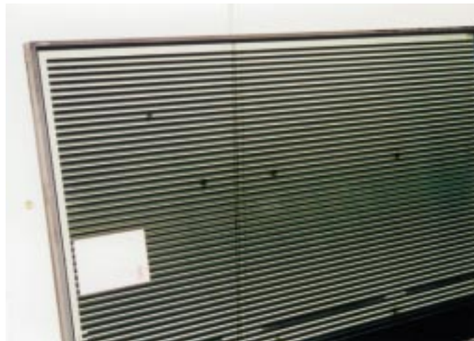
Die fertigen Elemente werden von BGT an Gartner geliefert, um dort in die Fassadenkonstruktion montiert zu werden – das zusätzlich im Siebdruckverfahren aufbrachte Streifendesign dient dem Sonnenschutz
