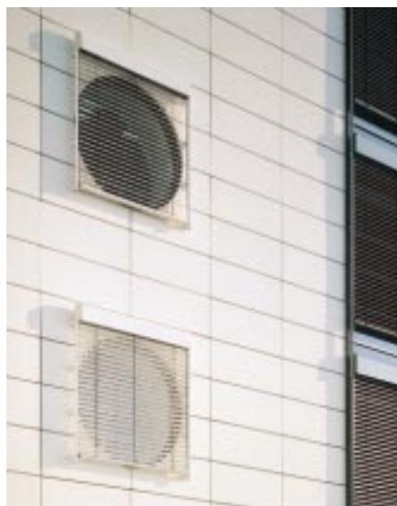
*Hitze- und Blendschutz an den nach außen orientierten Fassaden bieten 1500 Außenraffstores mit zentraler Steuerung in einem Metallic-Grauton*
