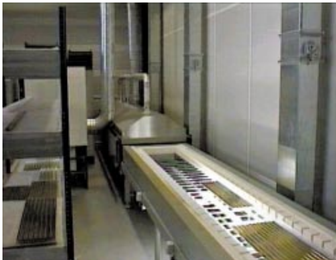
Reflektorrohre im Rollofen
