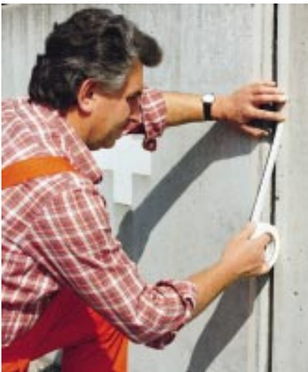
Bild 2: Vor dem Auftragen von Primern mit Eigenfarbe sind die Fugenränder zweckmäßigerweise mit Selbstklebeband abzudecken
