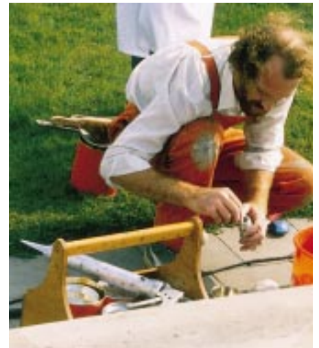
Bild 3: Öffnen des Blechgebindes mit „PCI-Elastoprimers 135“ erst unmittelbar vor dem Verarbeiten – angebrochene Gebinde sind baldmöglichst wieder gut zu verschließen
