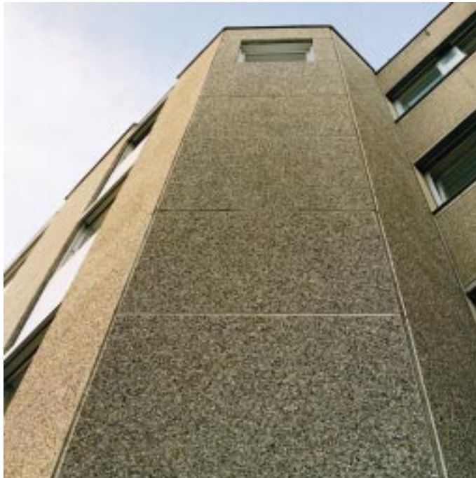
Bild 4: Eine große Rolle spielt der Einsatz entsprechender Primer bei Fugenabdichtungen gemäß der DIN 18 540 Bilder: PCI
