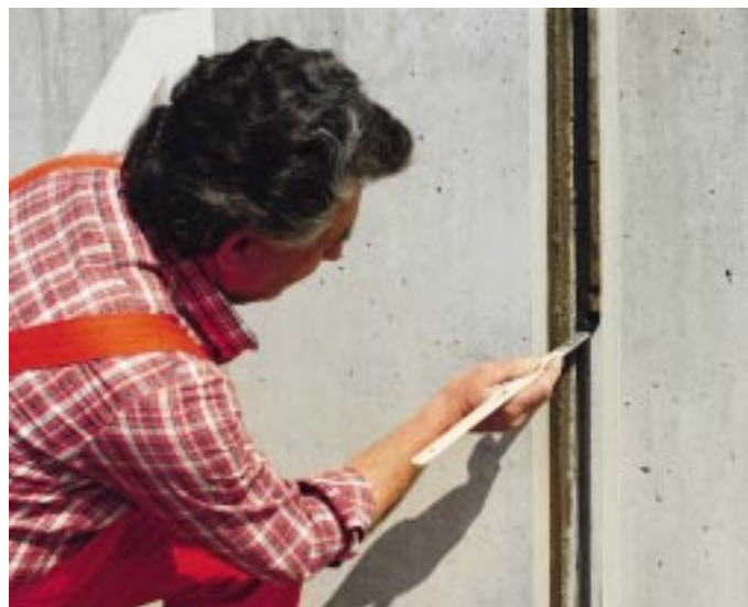
Bild 1: Verarbeiten eines Primers mit Eigenfarbe Bilder: Englmann
