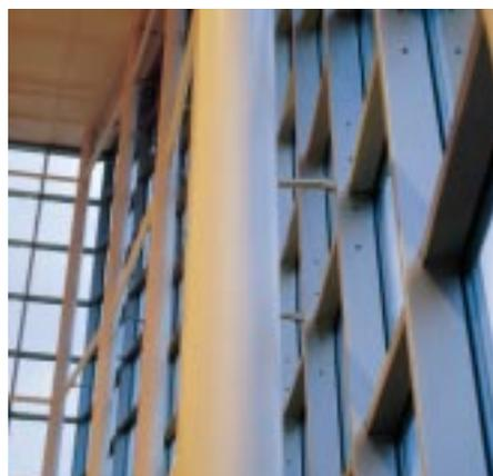
*Die verglaste Pfosten-Riegel-Fassade wird an der bauseitigen Stahlkonstruktion zum Abtragen der Windlasten abgestützt*
