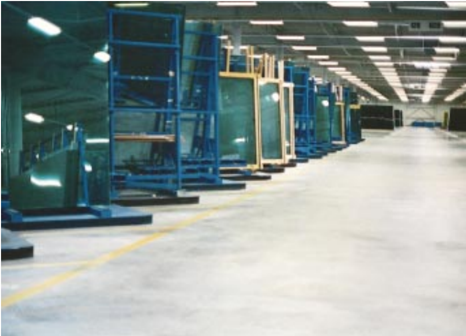
Der neue Betonboden im Glaswerk ist eben
