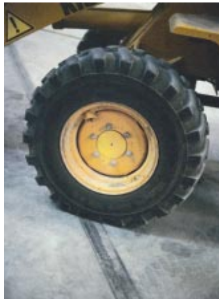
Ein Kantenschutzprofil bewahrt die Fugen vor Verschleiß
