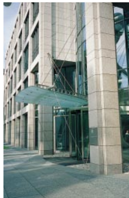
Für die Überkopffverglasung besonders vorteilhaft: die Verwendung von Verbund-Sicherheitsglas aus teilvorgespanntem Glas
