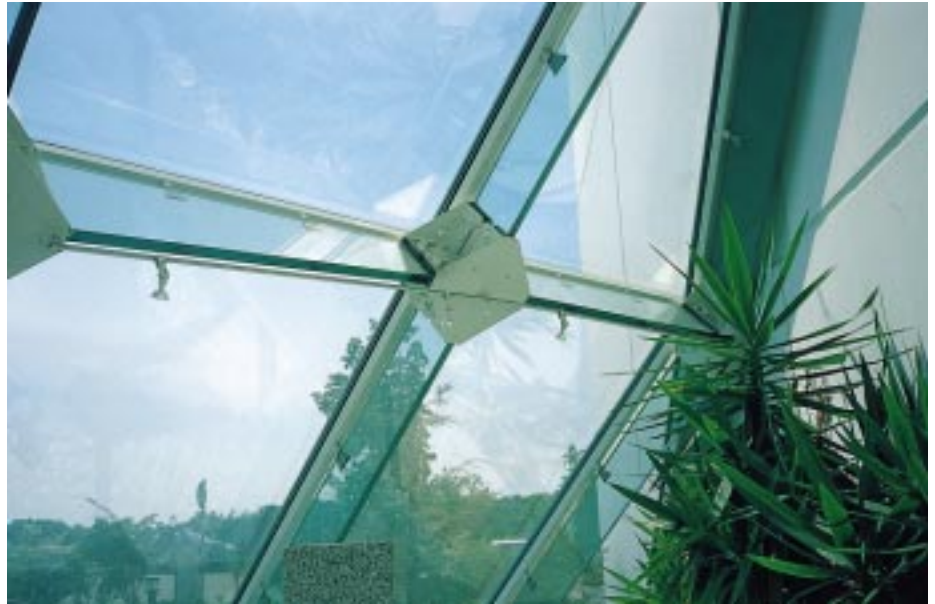
In vermehrtem Maße wird Glas auch in unterstützenden Konstruktionen (z. B. als Glasträger, Aussteifungsschwerter usw.) eingesetzt
