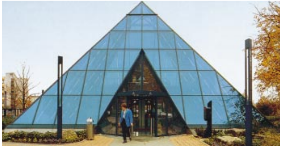
Die „MSH“-Profile dienen gleichzeitig als Warmwasser-Heizkörperflächen Bilder: V&M
