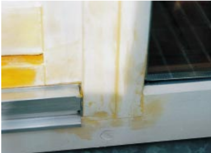
Detailaufnahme der Nachbesserungsarbeiten
