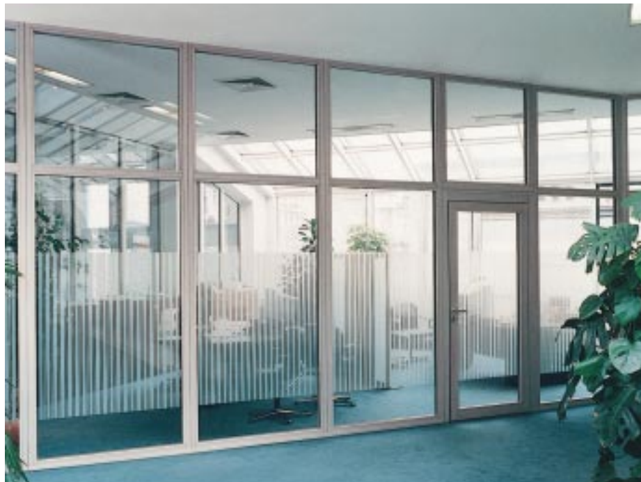
„Glas-ma“-Beschichtung als Sichtschutzmotiv auf einem Tür-Trennwandsystem mit „Pyrostop“ für F 30-Verglasungen
