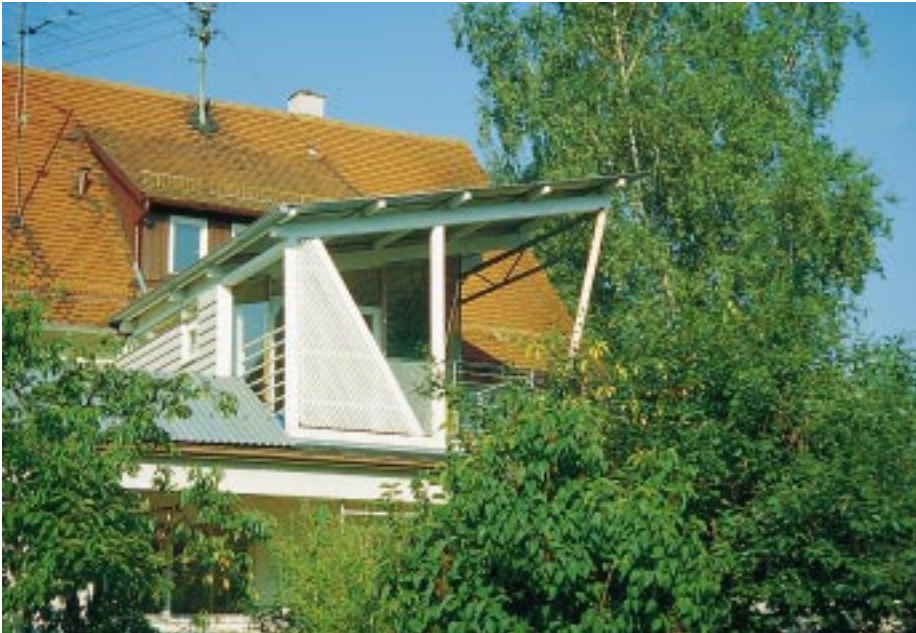
Bild 7: Erweiterung der Typologie „Wintergarten“: Reduzierte Glasflächen erhöhen die Nutzbarkeit
