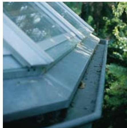
Bild 11: Isolierglas- und witterungsgerechtes Detail der Traufe
