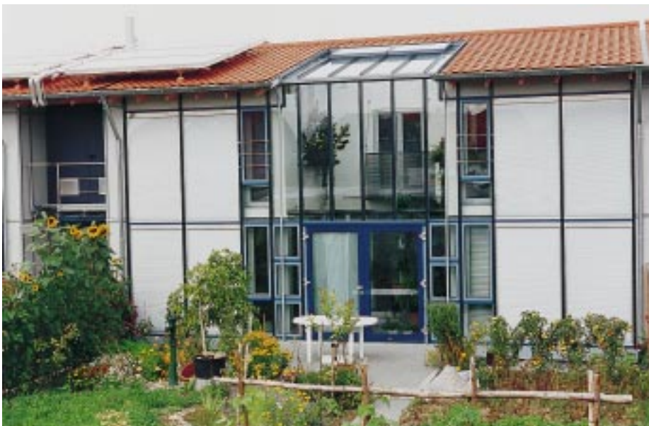
Bild 8: Nur ein integrierter Wintergarten ermöglicht bei temporärer Nutzung Energiegewinnung
