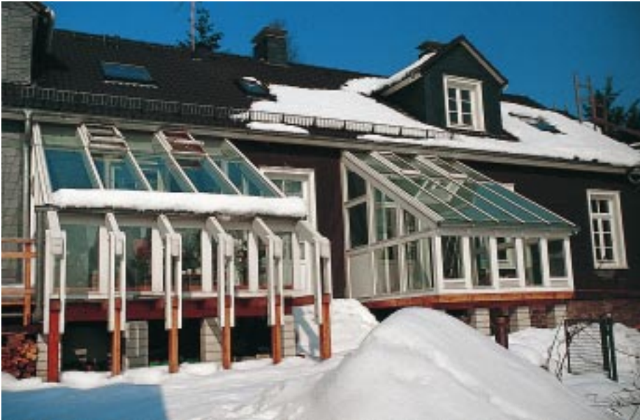
Bild 10: Die Teilverschattung der Scheiben durch nicht abrutschenden Schnee erhöht das Glasbruchrisiko
