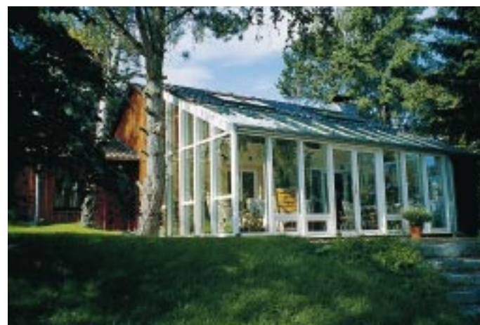
Bild 5: Klimagerechtes Wintergartenkonzept: Das teilmassive Dach beeinflusst die Einstrahlung nach den Sonnenständen
