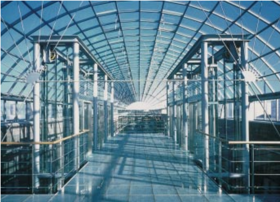
Eine filigrane Seilunterspannung stabilisiert statisch das gläserne Tonnendach des Forums und setzt zugleich optisch reizvolle Akzente Bilder: Interpane
