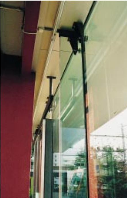
Detail oben – Aussteifung durch VSG-Schwerter
