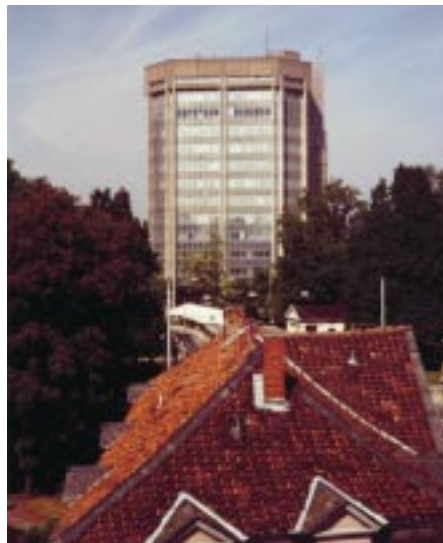
Ökologisch zwingend - ökonomisch vertretbar: die Sanierung des Bürohochhauses der TU Braunschweig
