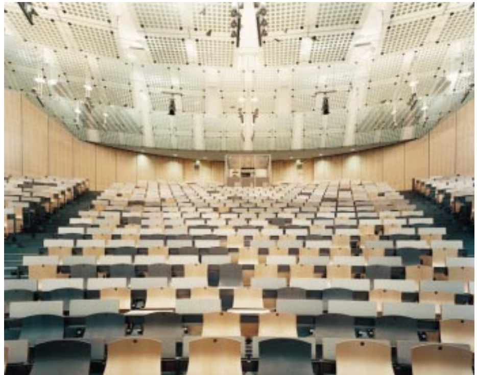
Die Architektur der neuen Fakultät für Maschinenwesen spielt vielerorts mit Kunst- und Tageslicht – hier die aufwendige Lichtarchitektur mit abgehängten, siebbedruckten Glasflächen in einem der Hörsäle Bilder: Pilkington
