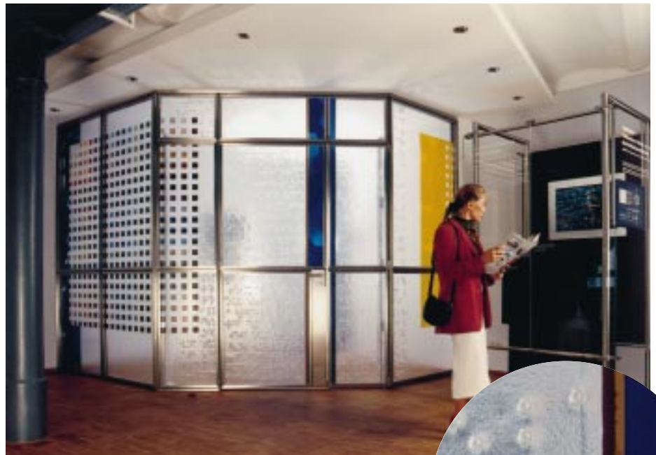
Detail einer Trennwand im Ausstellungsbereich von Schott Desag nach einem Entwurf von Thierry Boissel. Zu erkennen sind die im „Fusing-Prozeß“ Stoß an Stoß zusammengefügte Glasstücke, die Schmelzglasscheiben wurden im „Artista“-Forum in die vorgesehene Form gebracht und miteinander verschmolzen. Die Vielzahl der „Noppen“ ist indes nicht willkürlich angeordnet: In das Glas eingeschmolzen geben sie in Blindenschrift das Gedicht „Das Glaskristall“ von Paul Scheerbart wider
