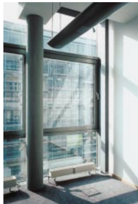
Die Edelstahlkreuzhalter wurden über Rundstäbe als Distanzen im Standardprofil verankert Bilder: Rischer
