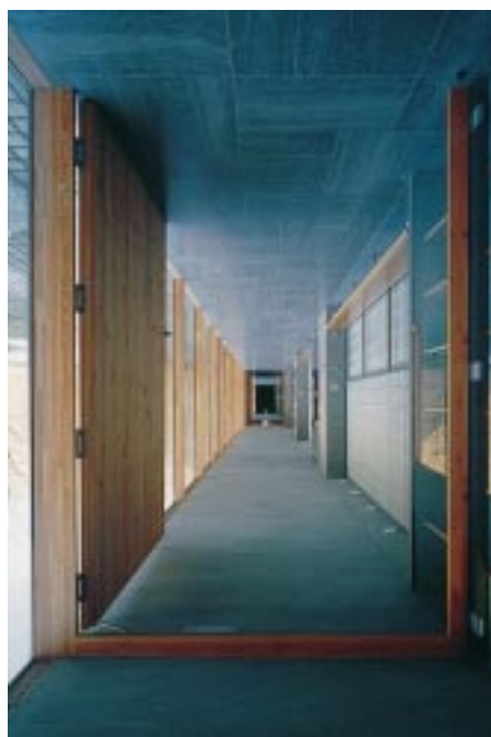
Brandschutz bei gleichzeitiger Lichtdurchlässigkeit: im Schulzentrum München-Riem dienen die Glassteine zur Begrenzung der Brandabschnitte zwischen den Klassenzimmern und dem Flur
