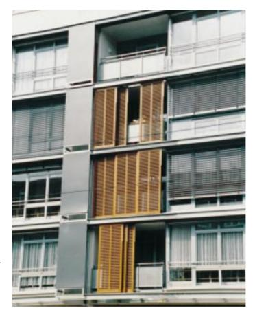
Individuelle Tageslichtsteuerung und wirksamer Sonnenschutz mit verschiebbaren Holzklappläden: das neue Lamellen-Schiebesystem ermöglicht zudem abwechslungsreiche Gestaltungsvarianten
