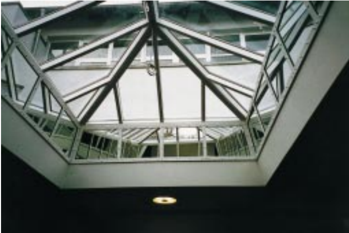
Walmdachkonstruktion G 30 über dem Aufenthaltsraum einer Rehaklinik mit verspiegelter Zarge – das Glasdach mit dem Brandschutzglas „Pyroswiss“ liegt in einer Art Innenhof und reicht in die 5-m-Zone zur aufsteigenden Fassade des Nachbartraktes hinein
