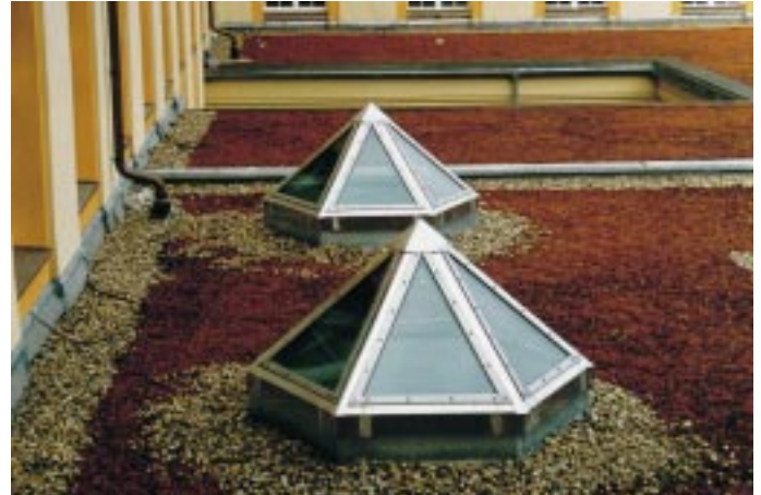
Sechseckpyramiden G 30 („Pyroswiss“) über der Cafeteria eines Schulzentrums, Lage auch hier innerhalb der 5-m-Zone zur angrenzenden Fassade mit Fensteröffnungen
