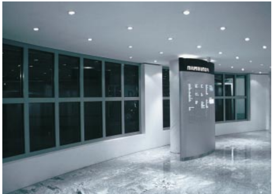
F-90 Glasabtrennung im Tiefgaragenbereich mit „Paraflam F-90/28 mono“ Sonderglas-aufbau Bild: Peter Schuhböck
