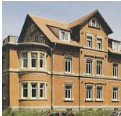
Das Buchbinder-Colleg befindet sich in der ehemaligen Villa Streicher, einem Bauwerk aus dem letzten Jahrhundert, das der neuen Nutzung angepaßt wurde
