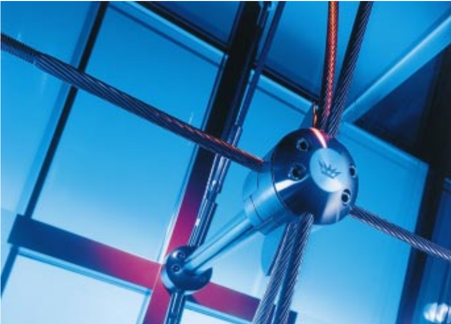
Neue Leichtigkeit in der Fassadentechnik: Eine unverwechselbare Optik entsteht durch ein transparentes Tragwerk, bestehend aus Edelstahlknoten und Seilen
