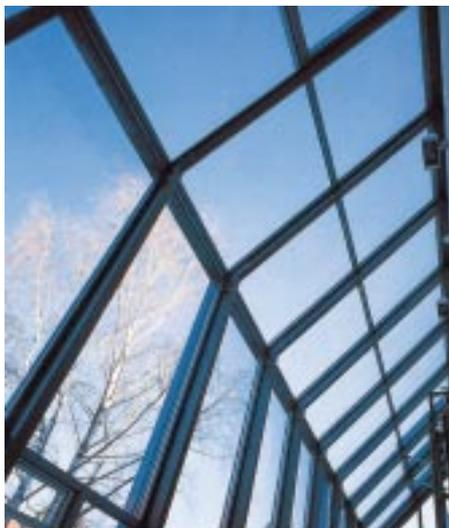
Schlanke Profile ermöglichen die optimale Nutzung von Sonnenenergie
