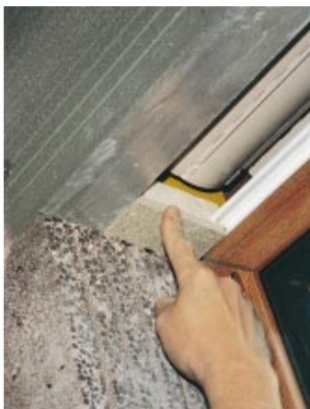
. . . Putzanschlußstücke einsetzen . . .
