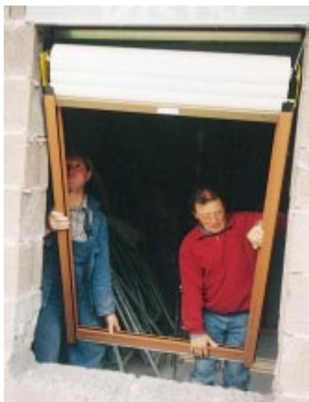
. . . „Fenro“ aufnehmen, in den Rolladensturzkasten einführen . . .
