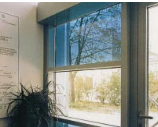
Bis Mitte 2000 soll das Entwicklungsprojekt „schaltbare Verglasung“ mittels gasochromer Schicht produktionstechnische Serienreife erlangen *Bild: Interpane*
