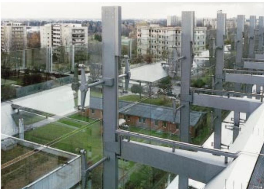
Die entlang der parallelen Schwenkachsen angeordneten Glaslamellen ermöglichen in jeder Stellung eine ungehinderte Sicht nach außen
