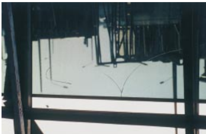
Bild 14: Thermischer Sprung bei stark absorbierender Wärme- und Sonnenschutzbeschichtung und nicht vorgespanntem Glas, Ursache Teilbeschattung; Nr. Period.-System: 1 B, Gruppen-Nr. 001
