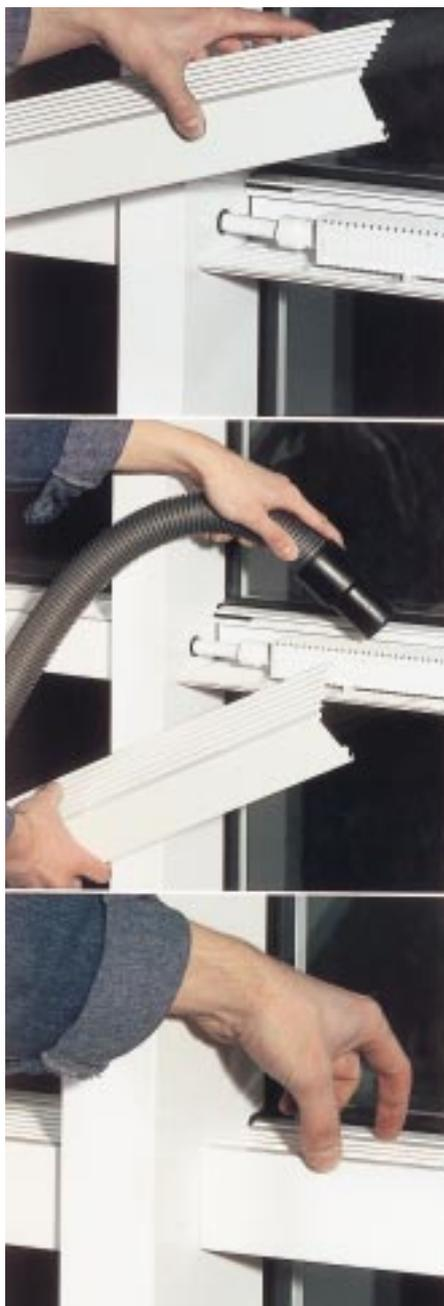
Die Klimaleiste kann direkt vor der Glasfläche auf den Riegel geschraubt werden; auch die Montage vor den senkrechten oder schräg nach oben laufenden Pfosten ist möglich – durch Abnehmen der vorderen Winkelprofile ist eine leichte Reinigung möglich
