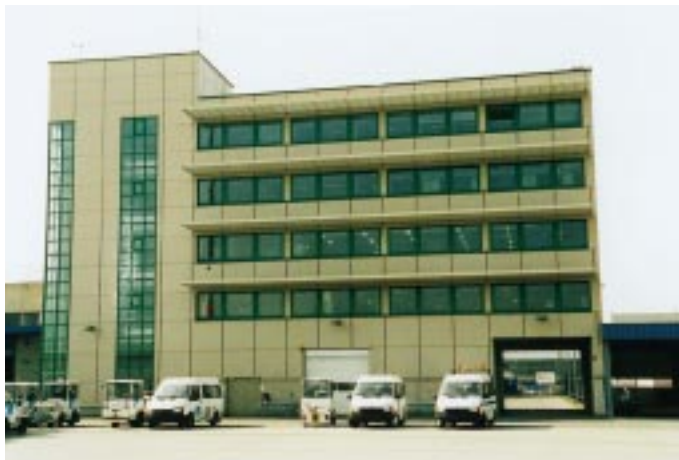
Zollgebäude Flughafen Köln/Bonn
