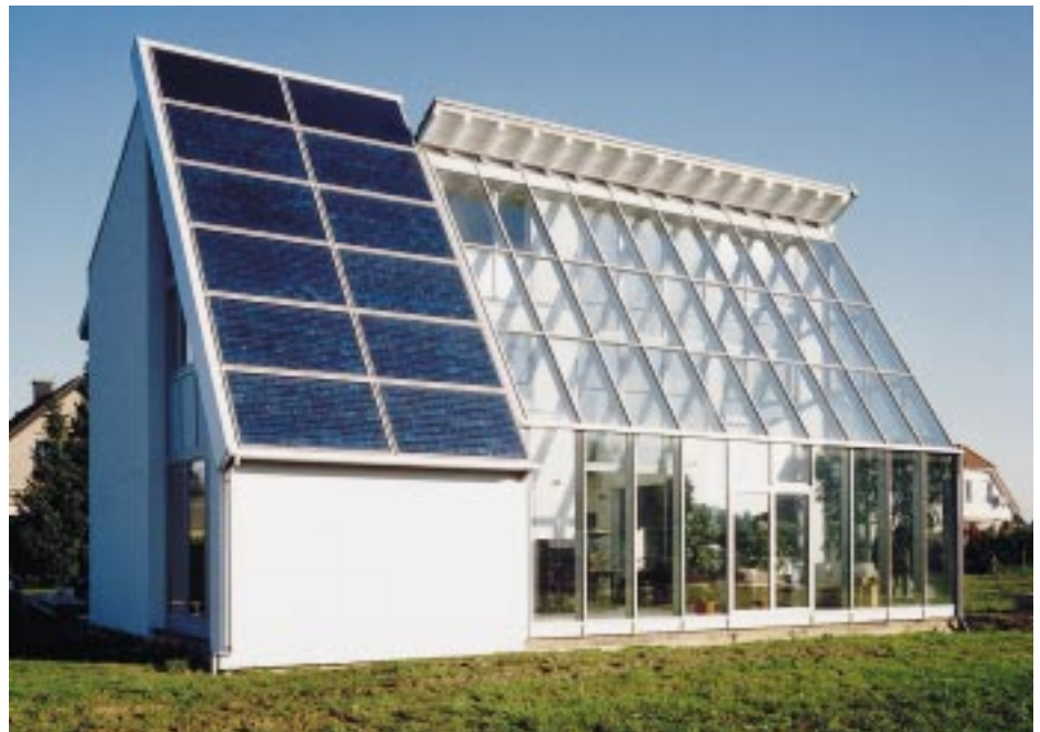
Bei diesem Haus in Enger wurden verschiedene Vorteile des Systemgedankens ausgeschöpft – PV und Thermie sind mit Schüco-Systemtechnik im gleichen Look in die Gebäudehülle integriert Bild: Schüco
