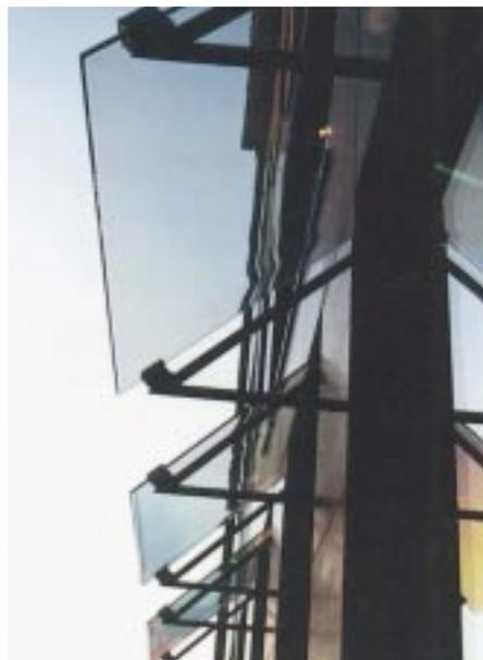
Diffuslichtlenkung kann mit Sonnenschutz kombiniert werden
