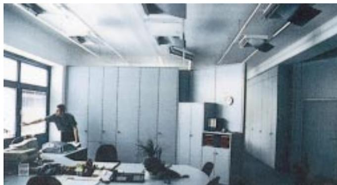
*Sonnenlichtlenkung hat gerade bei Büroräumen viele Vorteile: Energieeinsparung, blendfreie Ausleuchtung*
