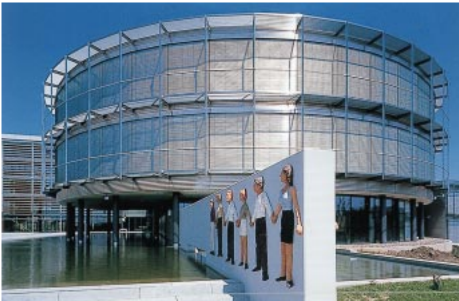
Die Außenraffstores mit Speziallackierung in Mattsilber nimmt die Optik der Edelstahlfassade auf (HUK Coburg)
