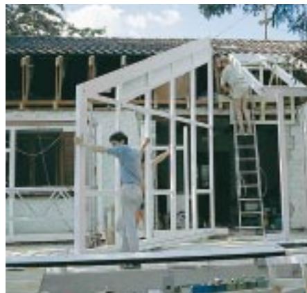
Energetische Sanierung durch eine vorgelegte Pufferzone aus einer thermisch nicht getrennten Gewächshaus-Stahlkonstruktion
