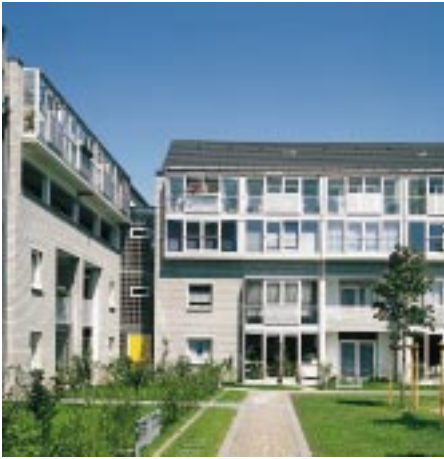
Nutzungserweiterung und Pufferzone: einfachverglaste, thermisch nicht getrennte Fertigteilkonstruktionen im sozialen Wohnungsbau
