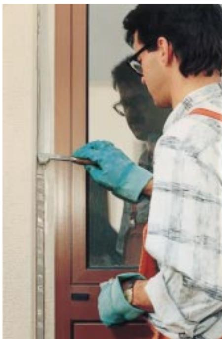
Bild 6: Zu den wesentlichen Kriterien eines Dichtstoffs für die Anwendungsbereiche des IVD-Merkblatts Nr. 9 gehört ein gutes Abzieh- und Glättverhalten
