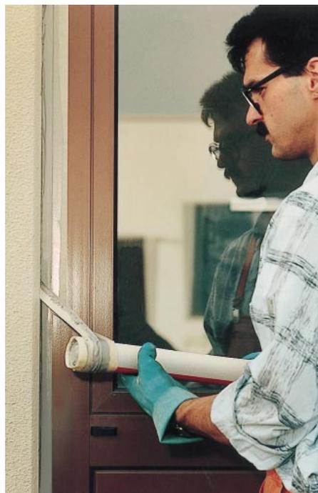
Bild 7: Nach dem Nachglätten ist das Selbstklebeband, mit dem die Fugenränder vor dem Ausspritzen des Dichtstoffs in die Anschlußfuge zwischen Fensterrahmen und Baukörper abgeklebt wurden, sofort wieder abzuziehen
