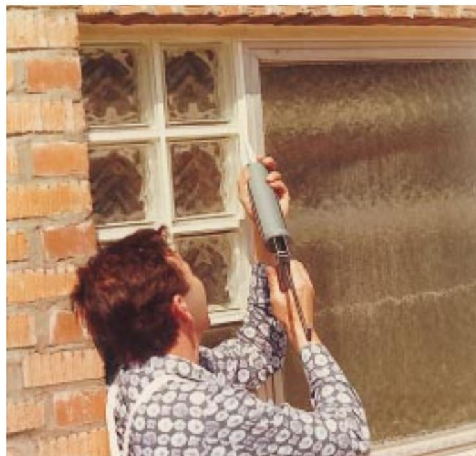
Bild 5: Für das Verarbeiten von Dichtstoff in senkrechten Anschlußfugen zwischen Fenster und Baukörper ist die Standfestigkeit eine wichtige Eigenschaft
