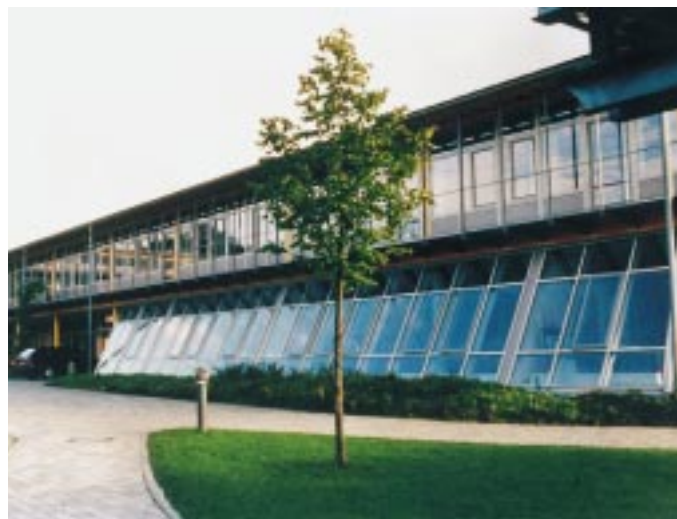
186 Überkopfverglasungen und 80 Senkrechtverglasungen am Gymnasium Raubling in Bayern
