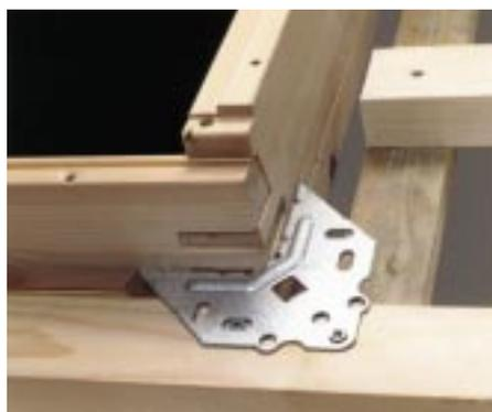
*Ein fachgerechter Einbau wird durch neue Montagewinkel leicht gemacht*
