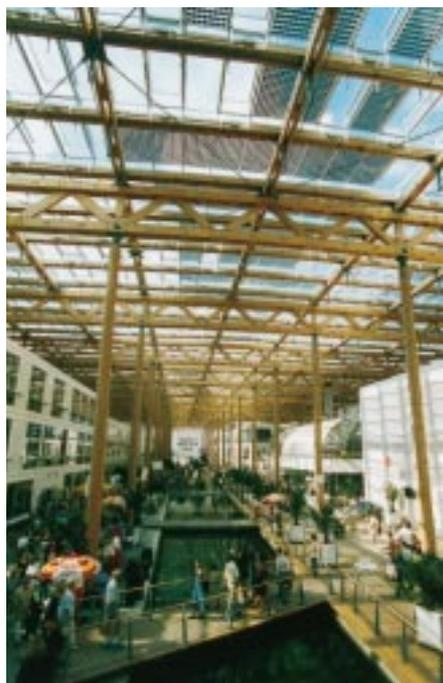
Die teiltransparenten Module sind lediglich zu 58 bis 86 Prozent mit Solarzellen bedeckt – dadurch gibt es reizvolle Licht-Schatten-Strukturen. Bilder: Bayer
