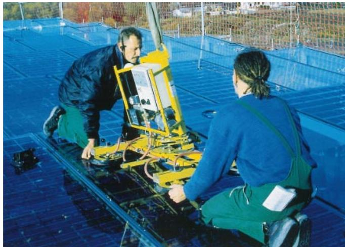
Das letzte der insgesamt 3184 Solarmodule wird in die gläserne Außenhaut installiert
