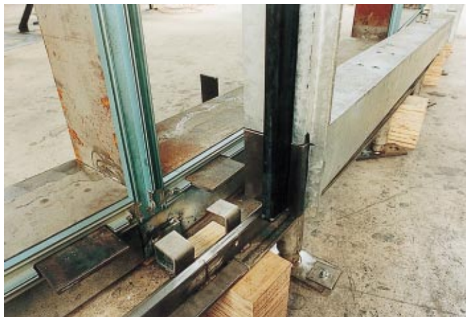
Die Fassade besteht aus verschweißten Stahlprofilen, auf die Aluminiumprofile geschraubt wurden, die das Glas aufnehmen
