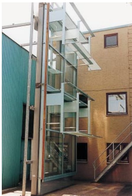
Bei der Zykloidfassade wurde ein begehrter Wartungsbalkon in den Sonnenschutz integriert
