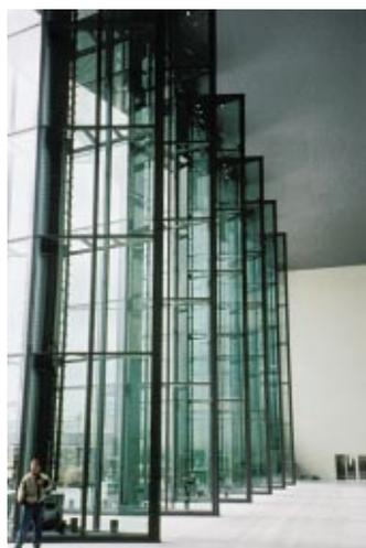
*Diese zwölf 20 m hohen und 6,5 m breiten Glas-Flügel Tore öffnen und schließen die Piazza des VW-Konzernforums in Wolfsburg. Dazu benötigen die lautlos arbeitenden Tore nur eineinhalb Minuten. Gefertigt wurden die transparenten Torelemente von der Sommer Stahlbau-Glasbau-Sicherheitstechnik GmbH & Co. KG aus Döhlau bei Hof/Saale. Die einzelnen Tore sind als Halbschalen ausgebildet und wurden intensiv auf Sicherheit und Funktionalität getestet.*
