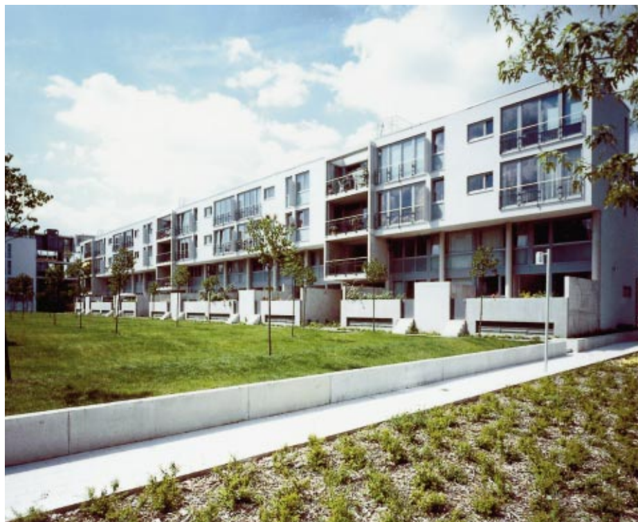
Das Gestaltungskonzept der Wohnanlage Rotherbaum in Hamburg setzt konsequent die typisch hanseatische Bauweise um: Geschlossene Häuserzeilen mit großzügigen Verglasungen umrahmen liebevoll gestaltete Hinterhöfe
