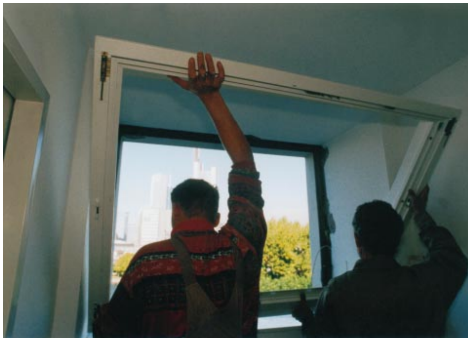
Bei alten Einfachverglasungen hilft nur der komplette Austausch von Glas und Rahmen um bessere Schalldämmwerte zu erreichen Bild: VFF
